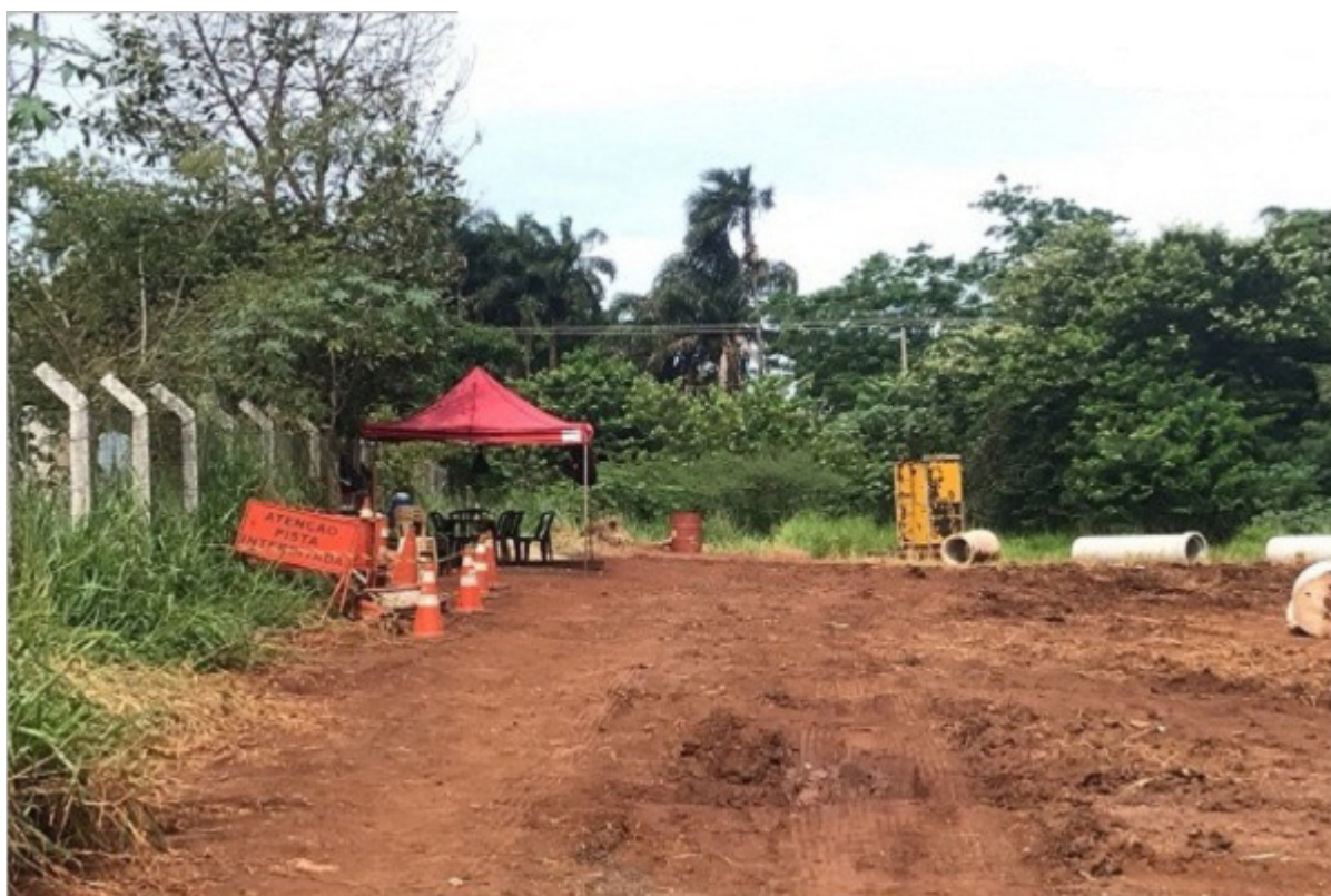
Figura 02 – Área de vivência e banheiro próximo da escavação. Fonte: Próprio Autor (2019).
