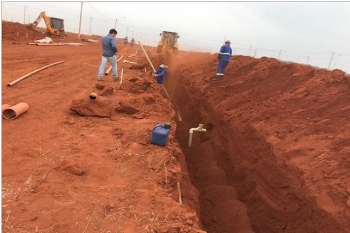
Figura 07 – Máquina escavando com funcionários dentro da vala e colaboradores sem EPI's. Fonte: Próprio Autor (2019).
