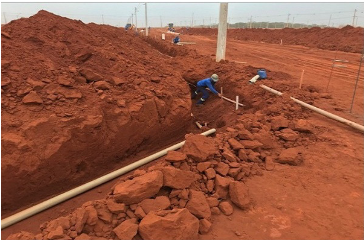
Figura 08 – Descarte de terra próxima da borda e falta de área de vivência e banheiros próximos dos funcionários. Fonte: Próprio Autor (2019).
