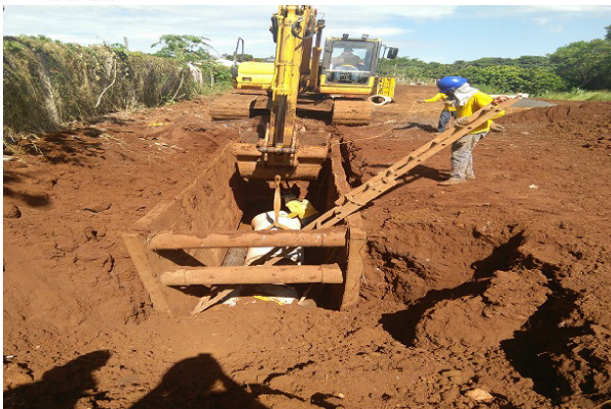
Figura 01 – Implantação de drenagem e esgoto Fonte: Próprio Autor (2019).
