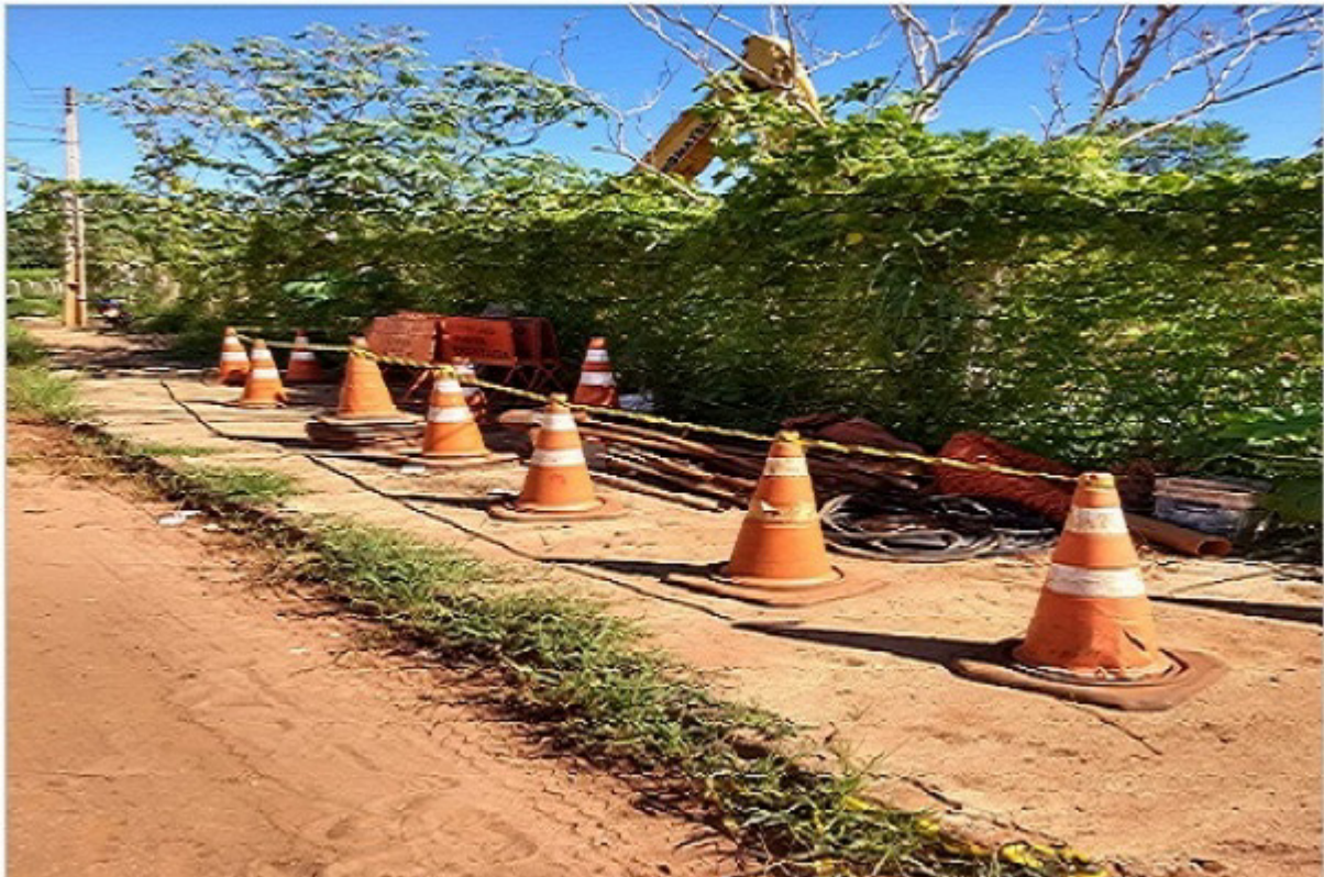
Figura 03 – Sinalização no entorno da obra. Fonte: Próprio Autor (2019).
