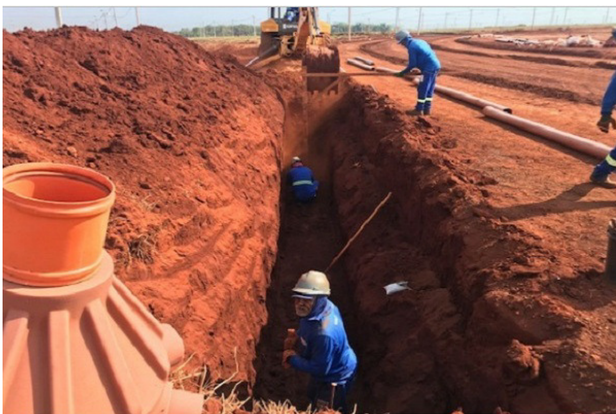
Figura 06 – Obra “C”- Funcionários sem EPI's e descarte do solo na borda da escavação. Fonte: Próprio Autor (2019).
