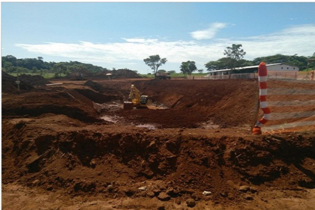
Figura 04 – Sinalização. Fonte: Próprio Autor (2019).
